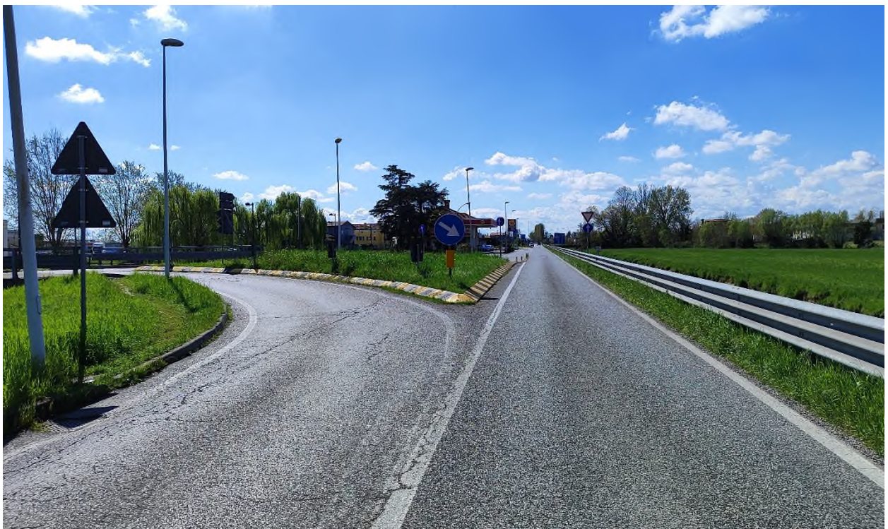
Figura 2.22 – Intersezione 1 - vista dal ramo D
